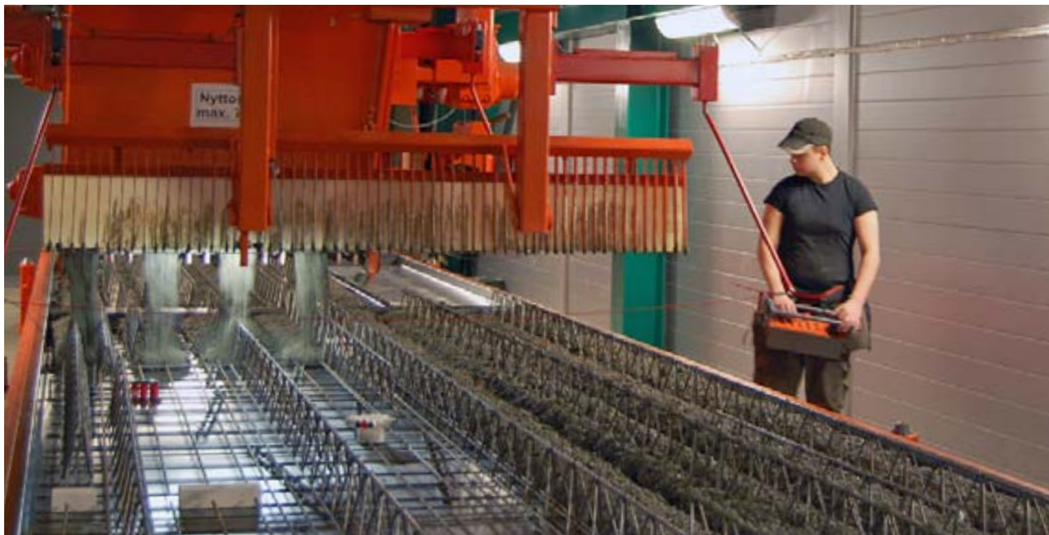
Monterad och klar. Elementen levereras med håltagningar och är förberedda för installationer.
