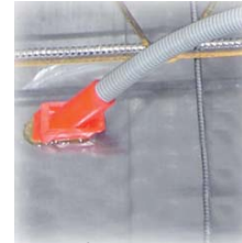
Elgenomföring vägg med flexislang
